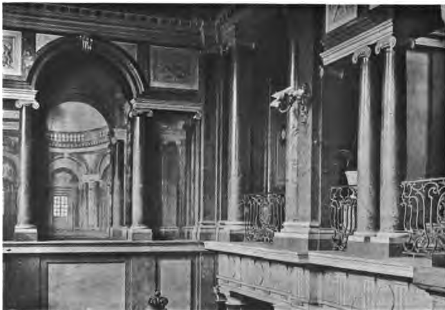
Château de Stockholm. Escalier occidental.
